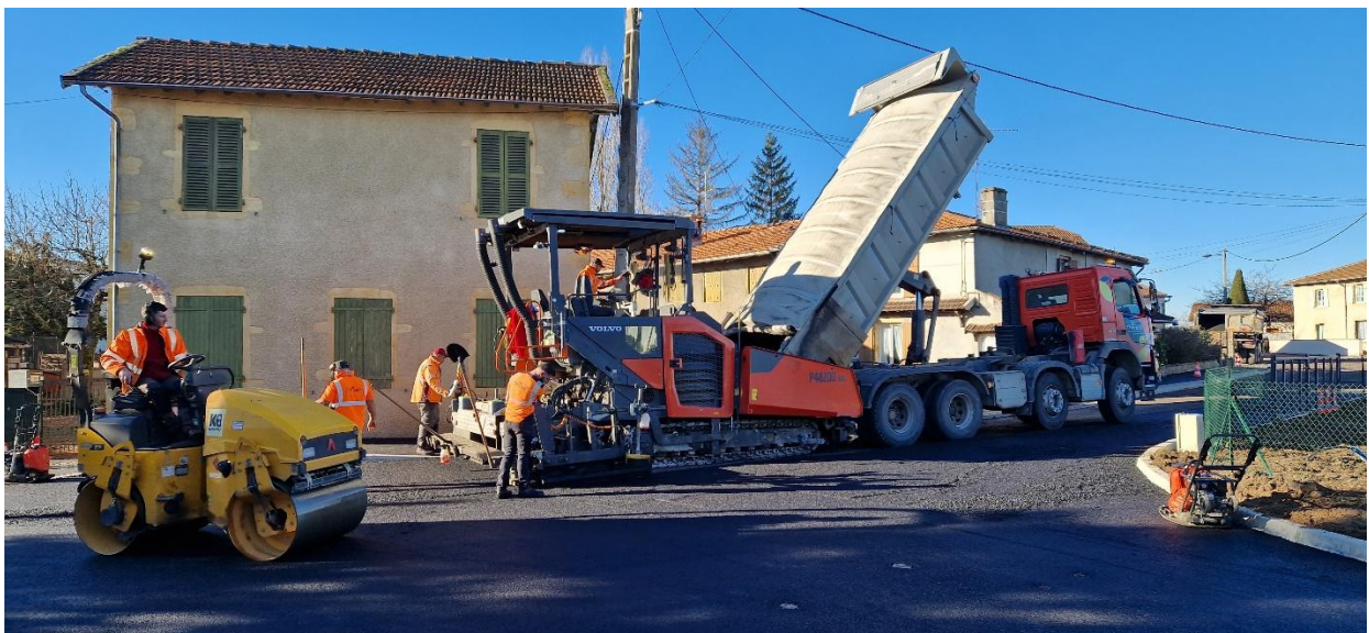
L'entreprise Thivent a réalisé les travaux d'aménagement et de sécurisation de la Rue de la Mairie.
